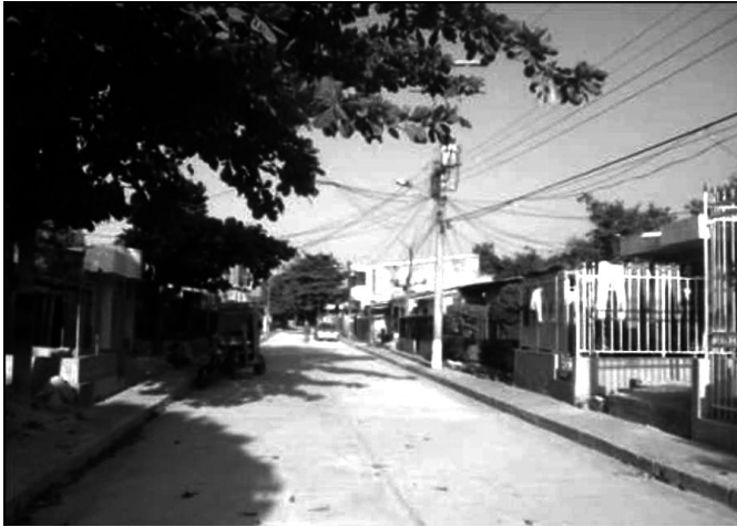
Fotografía 7. Calle Cuarta de las Flores, primera calle pavimentada del sector Primero de Mayo.
